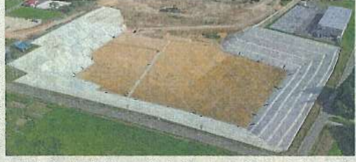
竣工した第4期管理型最終処分場
